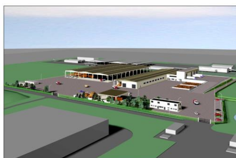
Impianto di produzione compost
